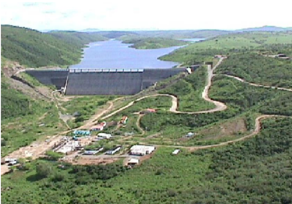
Barragem do Jucazinho-PE
