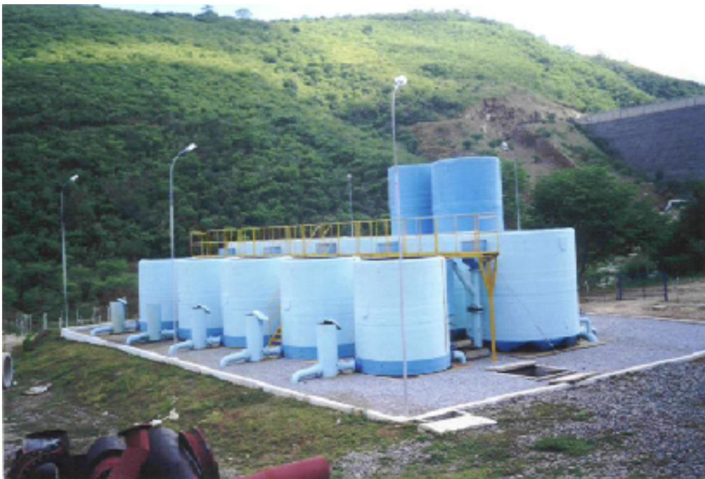
Estação de tratamento d'água compacto. Sistema Jucazinho-PE.
